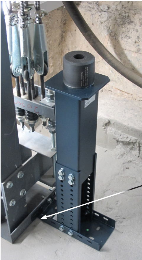
Exemple : Fixation au support du piston
