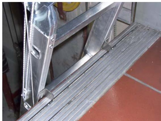
Befestigen Sie die Kette an der Schachttürschürze so, dass diese von der Schachttüre aus erreichbar ist. Prüfen Sie vorab, ob der Abstand zwischen Fahrkorb- und Schachttürschürze min. 15mm beträgt, ansonsten muß eine alternative Befestigungsmöglichkeit in der Nähe der Aufzugtüre gewählt werden.
