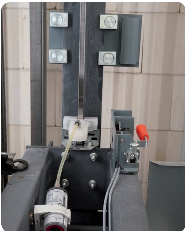
Einbaubeispiel Fahrwegbegrenzer im Aufzugschacht
