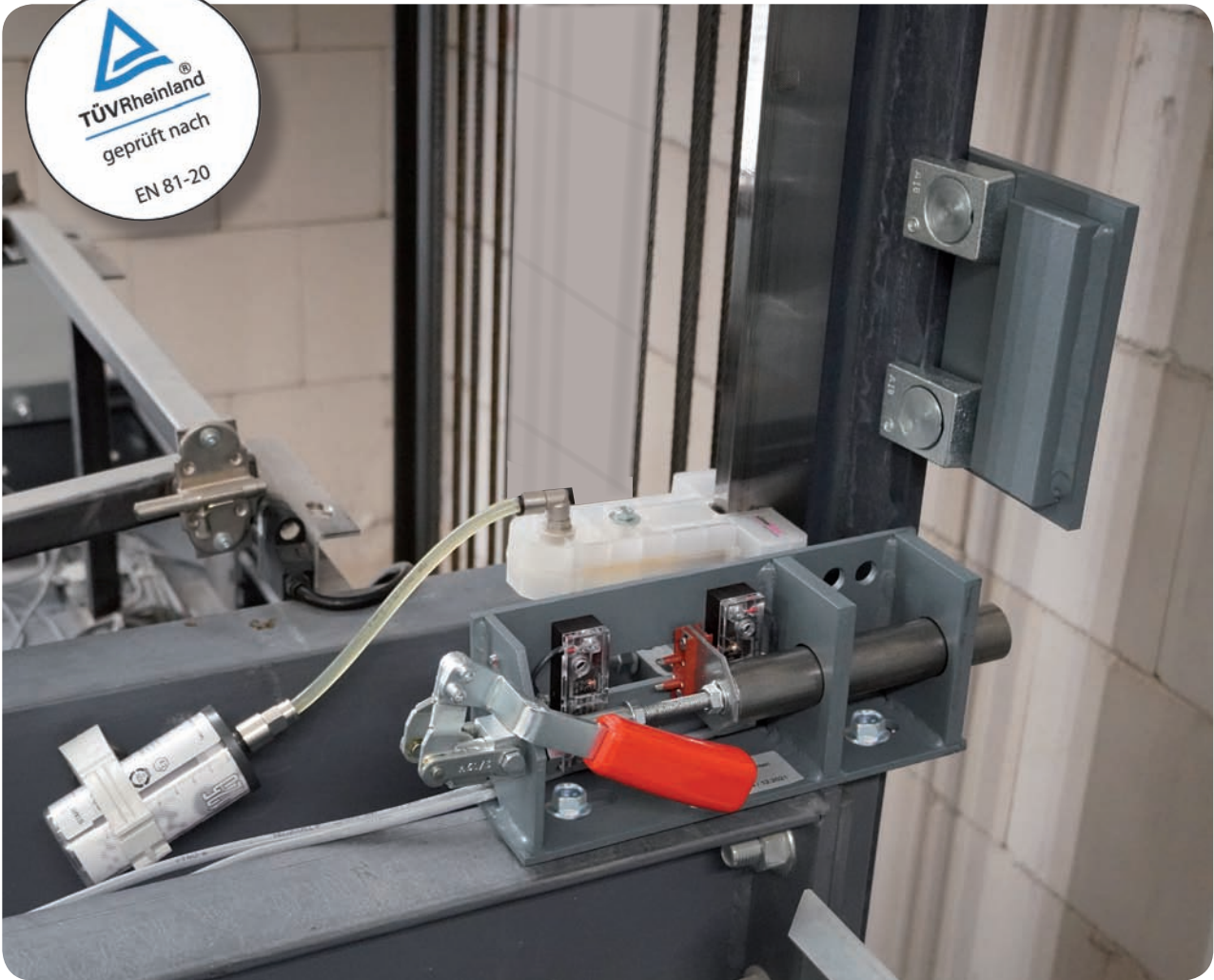
Einbaubeispiel Fahrwegbegrenzer im Aufzugschacht
