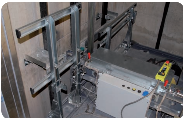
Einbaubeispiel für Geländer KLAPP und TELESKOPIERBAR
