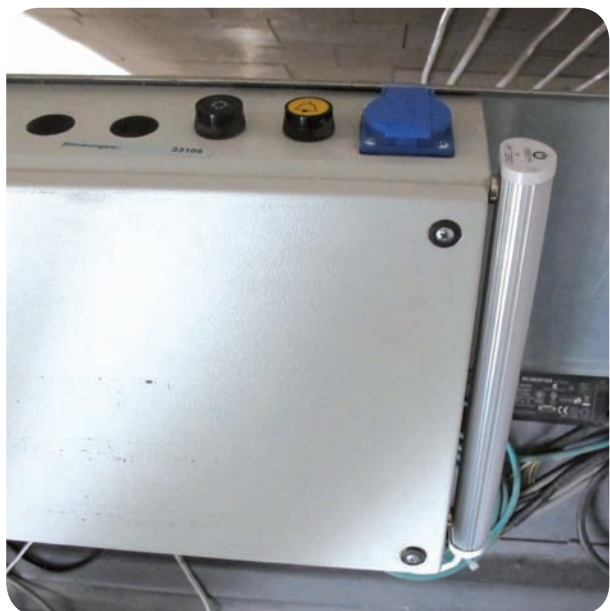
Befestigung der W+W Notleuchte am Dachsteuerkasten.
