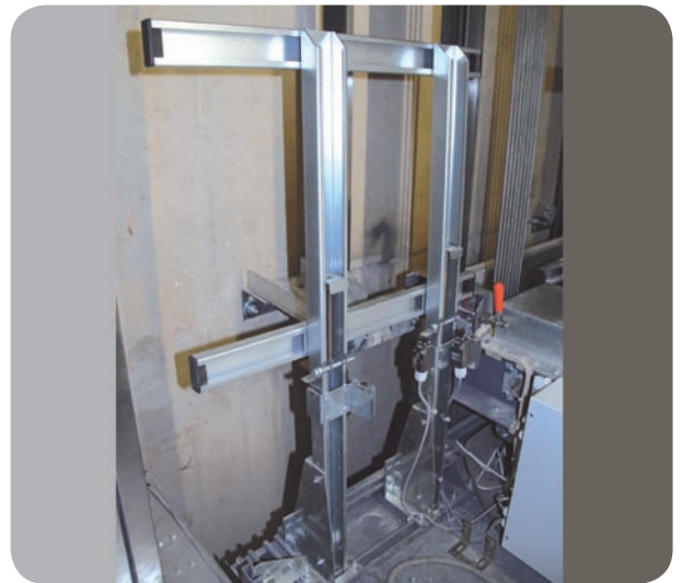
Einbaubeispiel Geländer aufgeklappt
