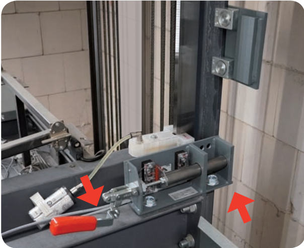
Freigabehebel steht oben, Bolzen ist eingefahren
