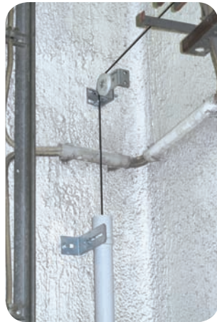
A Befestigung der Umlenkrolle auf Rollenwinkel
