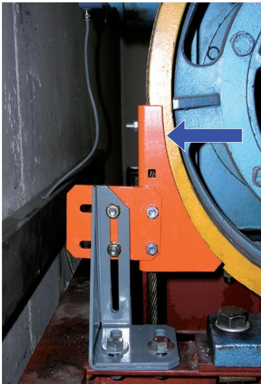
Am Ende den komplett montierten Schutz nochmals ausrichten und alle Schrauben festziehen.
