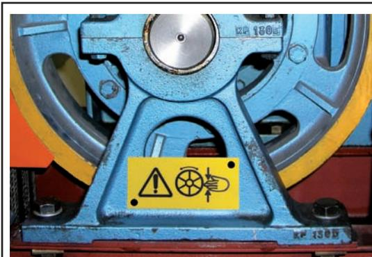
Das Warnschild muss in der Nähe der Treibscheibe / Umlenkrolle gut sichtbar befestigt werden, z.B. auf dem Maschinenrahmen oder am Lagerbock (siehe Bild).
