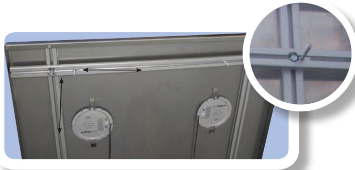
El falso techo preinstalado se fija con 4 pernos roscados en el techo de la cabina.
