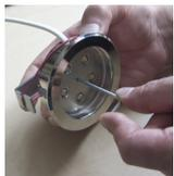
Schliessen Sie die Lampen an und montieren Sie diese in die dafür vorgesehenen Deckenöffnungen.
