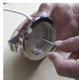
Raccordez les lampes et montez celles-ci dans les ouvertures du plafond prévues pour cela.
