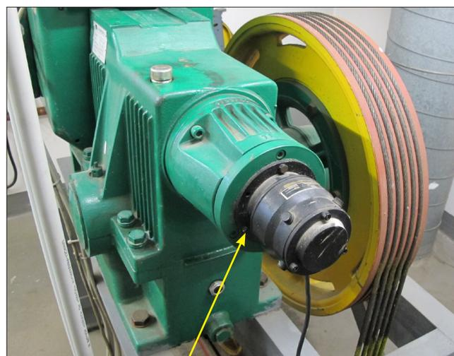
Schrauben am Tachogenerator entfernen
