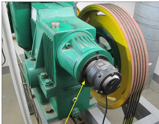
Schrauben am Tachogenerator entfernen
